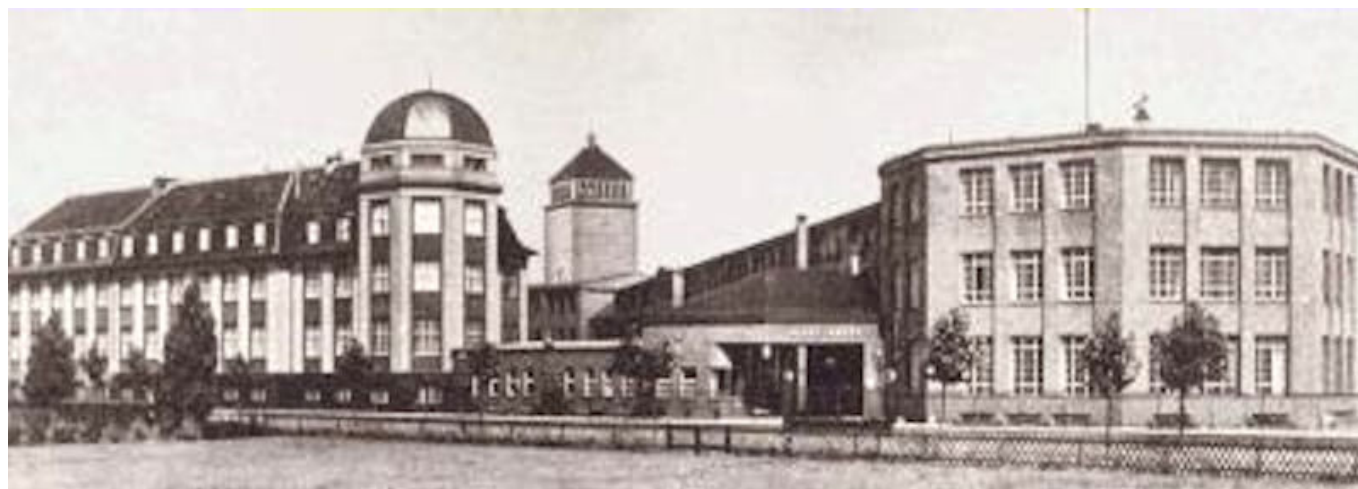
Fig. 78: Company buildings of Ziehl-Abegg Elektrizitätsgesellschaft m.b.H in Berlin-Weißensee
