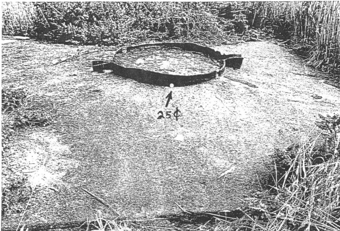
PTB/ Fig. 7 : Mast base
